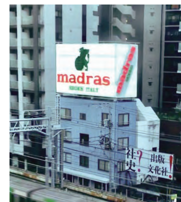
港区 伊藤ビル
