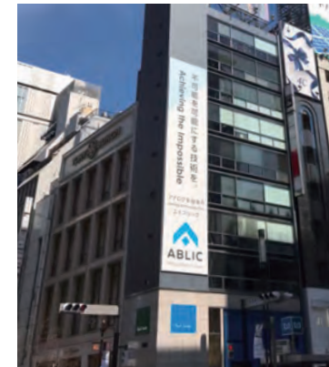
銀座中央ビル
